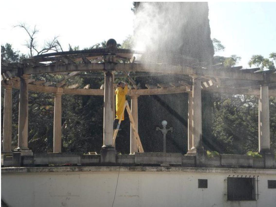
Con la limpieza de la fachada y la eliminación de malezas, suciedad y brotes que agravan la corrosión y las fisuras existentes en paredes y molduras, avanzan los trabajos de recuperación del Teatro del Lago “Martín Fierro”, ubicado en el Bosque platense.
