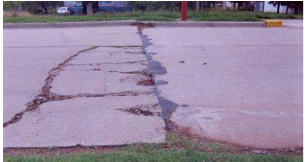
***Se establecen metodologías para evaluar la presencia de minerales reactivos y la expansión potencial en el hormigón.***
